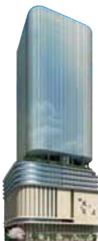
NAKANOSHIMA FESTIVAL TOWER 中之島フェスティバルタワー
